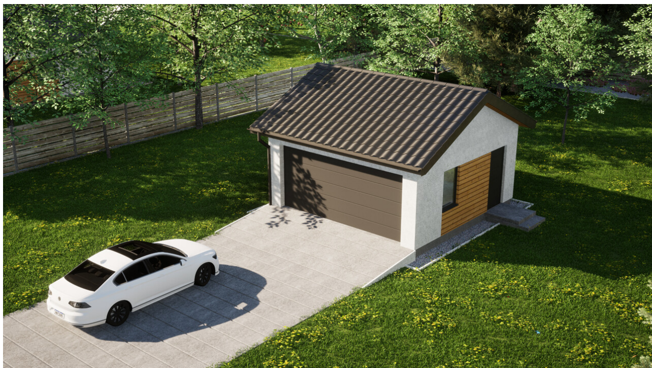
Garaż ERDOL G2 - Wersja prawa - Układ kalenicy równoległy z dachem dwuspadowym o kącie nachylenia 25 stopni - Brama segmentowa z napędem IO, sterowana pilotem - UniPro WISNIEWSKI - Antracyt
