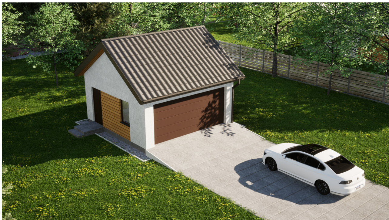
Garaż ERDOL G2 - Wersja lewa - Układ kalenicy równoległy z dachem dwuspadowym o kącie nachylenia 35 stopni - Brama segmentowa z napędem IO, sterowana pilotem - UniPro WISNIOWSKI - Orzech
