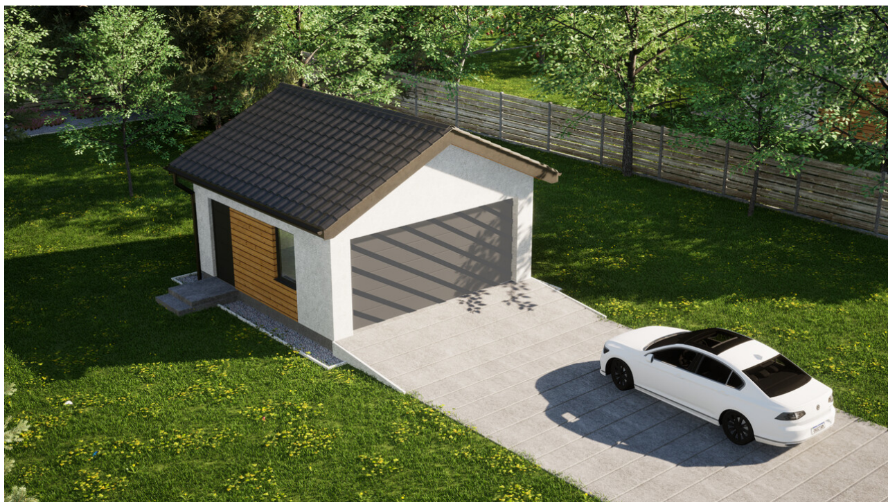
Garaz ERDOL G2 - Wersja lewa - Układ kalenicy prostopadły z dachem dwuspadowym o kącie nachylenia 25 stopni - Bez bramy - Antracyt
