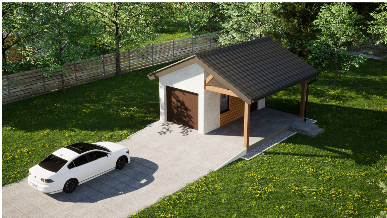
Garaż ERDOL G1W - Wersja prawa - Układ kalenicy prostopadły z dachem dwuspadowym o kącie nachylenia 25 stopni - Brama segmentowa z napędem IO, sterowana pilotem - UniPro WIŚNIEWSKI - Orzech
