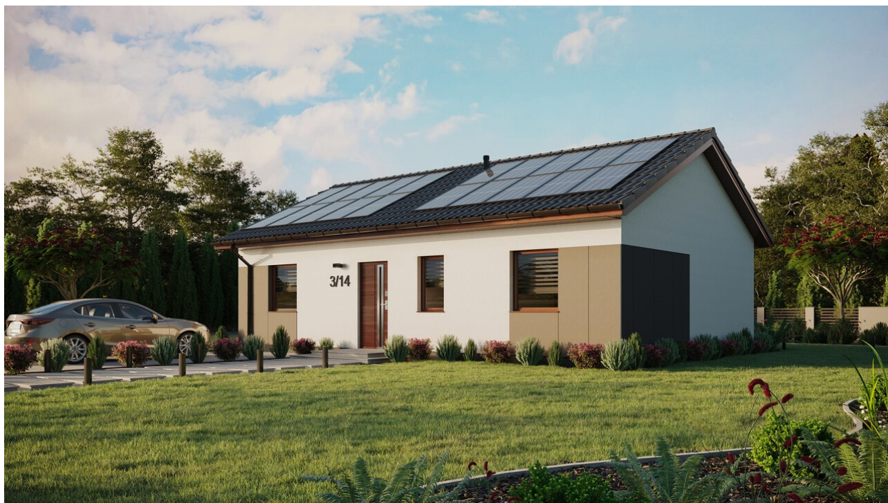
Projekt ERDOL 3 - Wersja lewa (salon po lewej stronie) - Dwuspadowy bez poddasza użytkowego - kąt nachylenia 25 stopni - Bez okien/świetlików dachowych - Okna standardowe - Styropian, siatka i klej - Orzech - Instalacja fotowoltaiczna 8,0 kWp (20 paneli)
